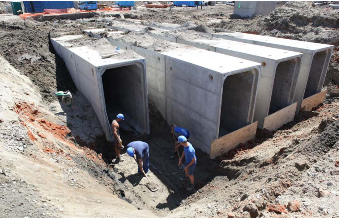
Met prefab betonnen kokerelementen creëer je snel een grote ondergrondse buffercapaciteit. (© Webeco)
