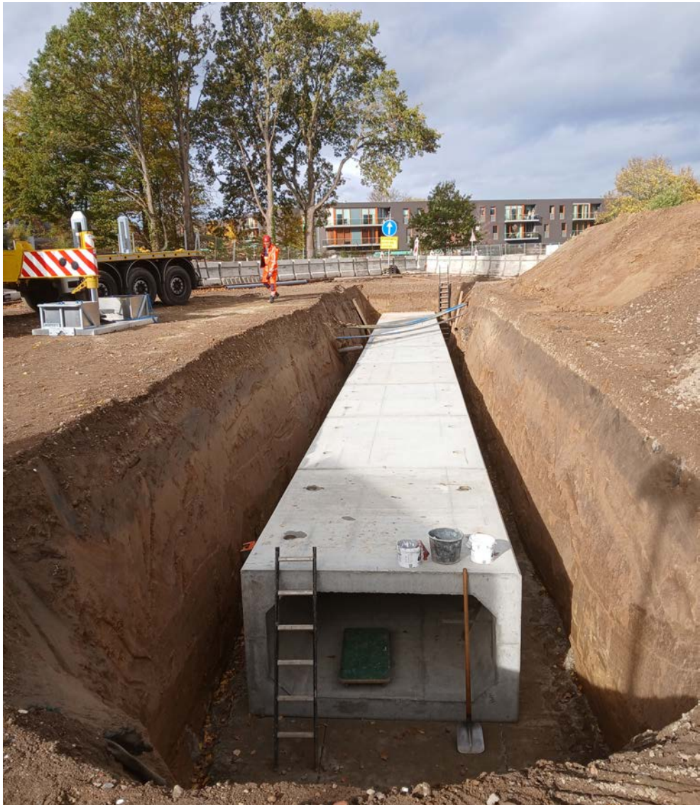
In België worden prefab betonnen kokerelementen voornamelijk ingezet voor riolering, waterbeheer en watertransport. (© Tubobel Aqua)
